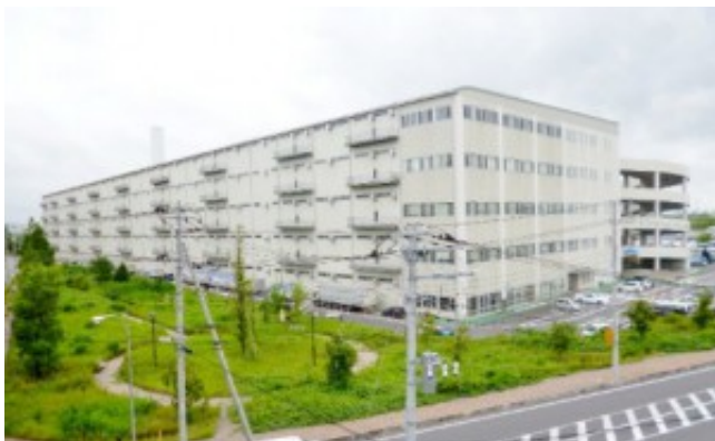
ロジポート流山（千葉県流山市）
