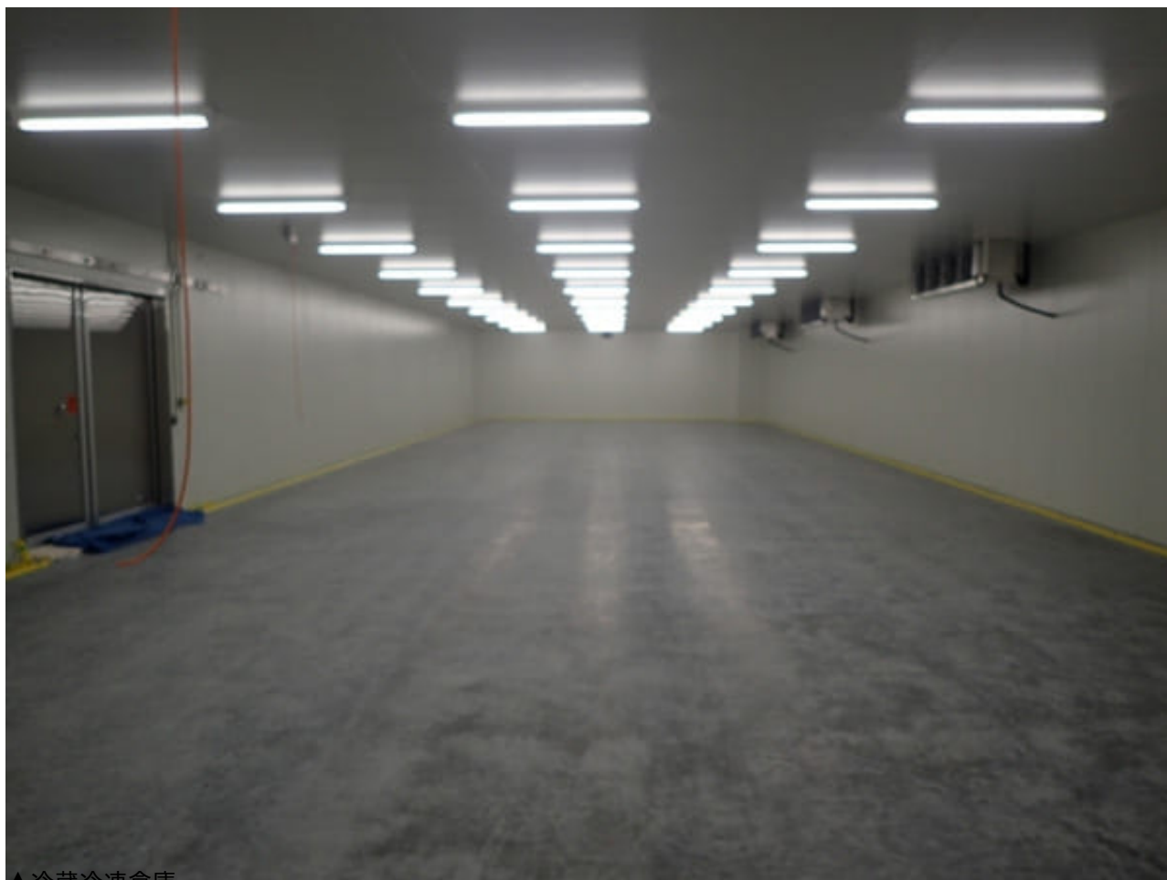
▲冷蔵冷凍倉庫
