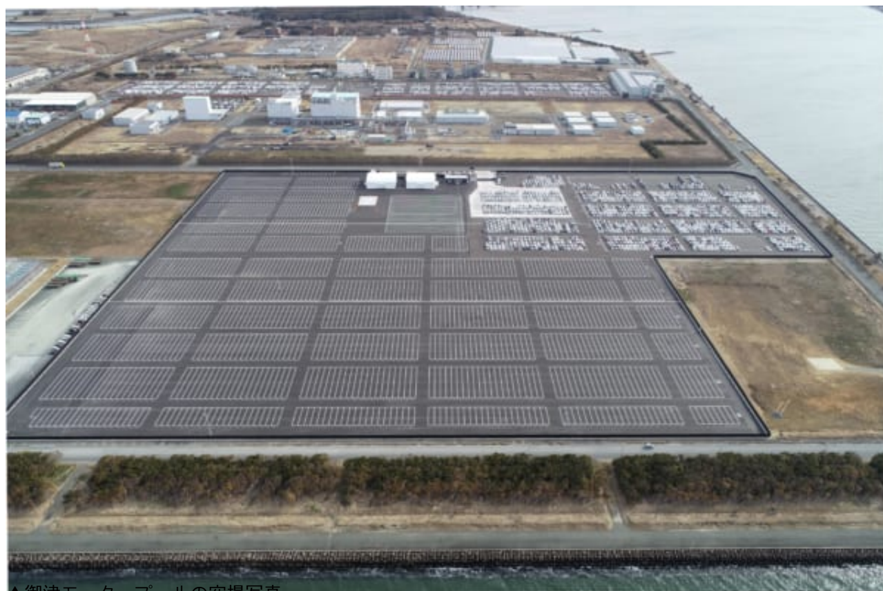
▲御津モータープールの空撮写真
