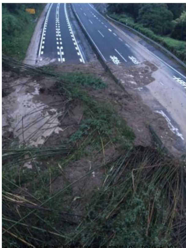
▲九州自動車道「溝辺鹿児島空港10～加治木JCT」下り線の土砂崩れの様子
