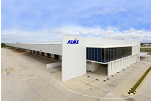
ピントンロジスティクスサポートセンターの外観
