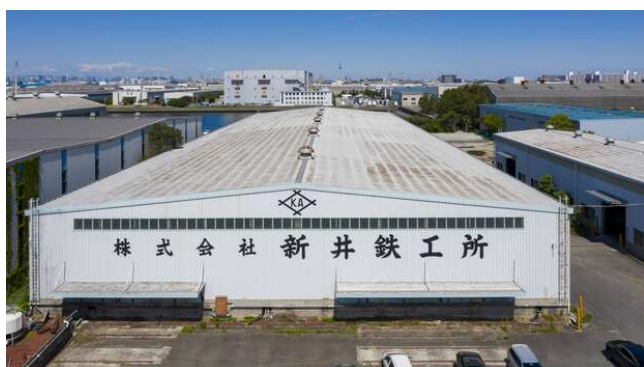
▲旧・新井鉄工所浦安工場
