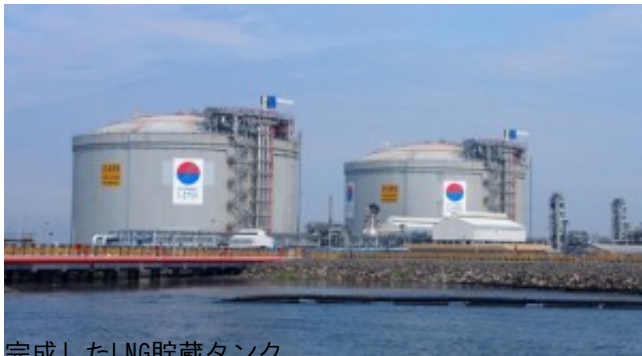
完成したLNG貯蔵タンク
