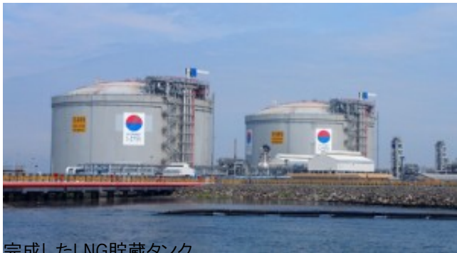
完成したLNG貯蔵タンク
