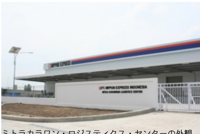
ミトラカラワン・ロジスティクス・センターの外観
